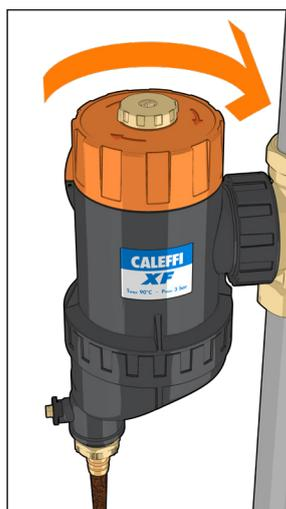
4. Al termine della pulizia, allineare l'indicatore della manopola superiore con il riferimento presente sul corpo del dispositivo. Richiudere il rubinetto di scarico ed avviare l'impianto.
